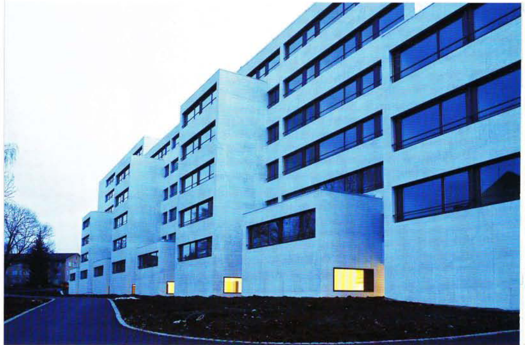
Eingangsbereich (Richtung Birmensdorferstrasse): Die Treppenhäuser sind mit einer langen Passage verbunden. Hier finden sich auch die zumietbaren Bastelräume.
